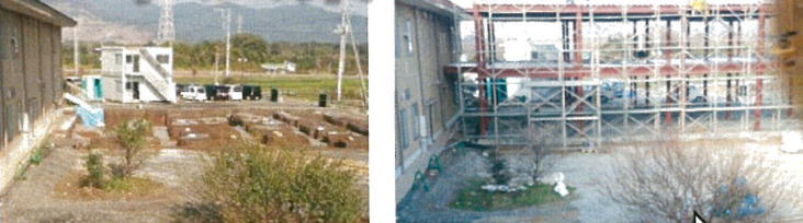
12月に工事着工し、みるみる出来ていきました
